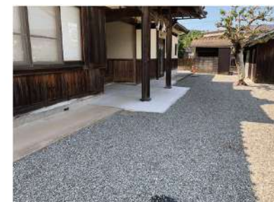
社務所玄関改修/庭の砂利敷き
