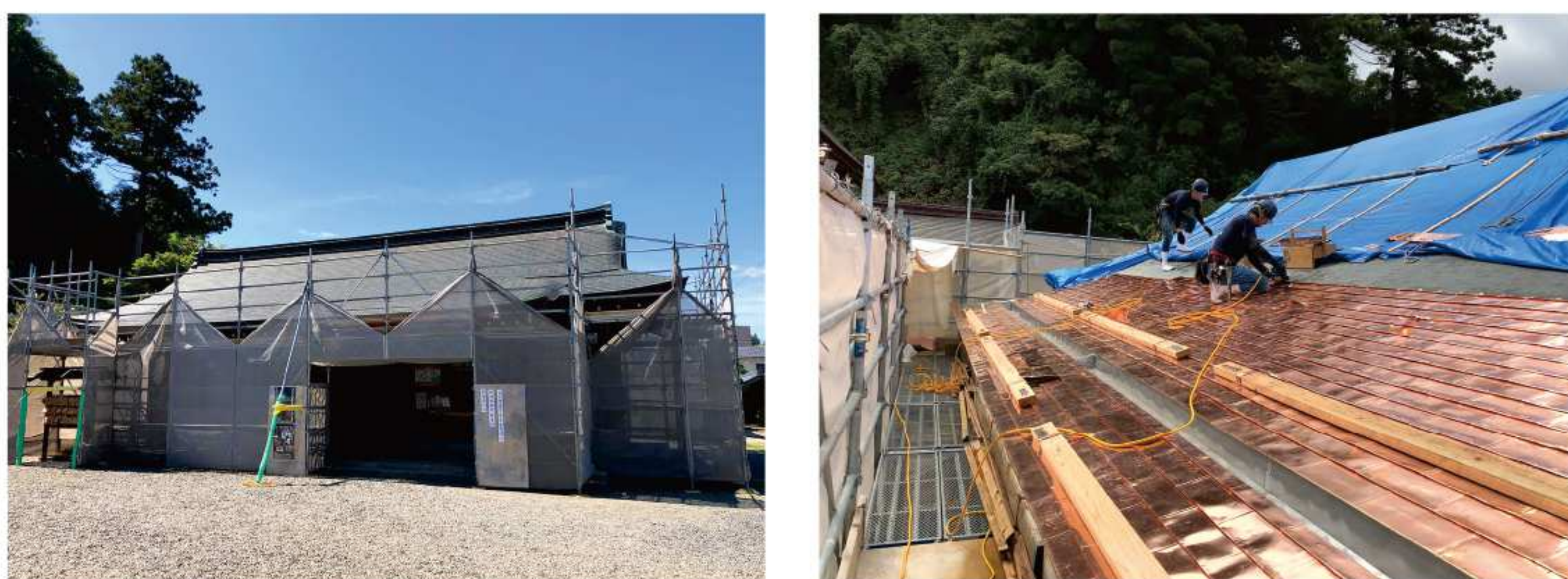
直会殿修復工事 設計：石原社寺建築設計事務所 施工：松江土建 株式会社
