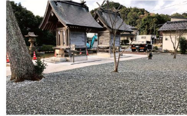
田中神社境内碎石敷 田中神社柵設置工事
