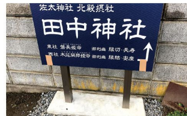
田中神社誘導看板基礎工事
