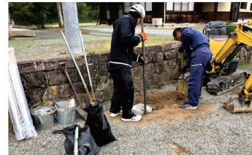
横馬場 侵入防止ポール設置
