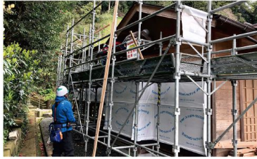
御仮殿修復工事 施工／株式会社 佐藤組
