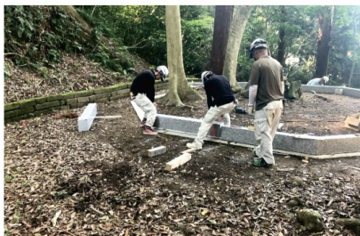
母儀人基社基壇整備 基壇石掘付状況
