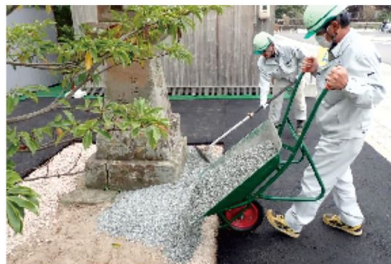
燈籠付近 敷均し状況
