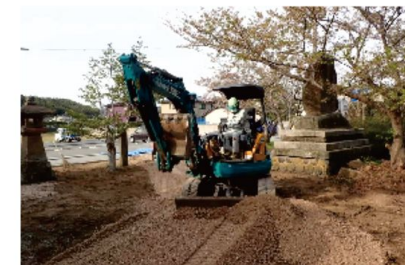
宇多貴社跡 路盤工敷均し状況
