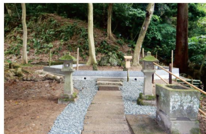
母儀人基社基壇整備 完成
