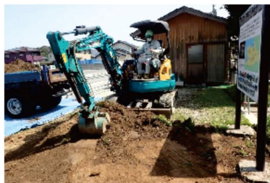
縦馬場南側付近 表土剥き取り状況
