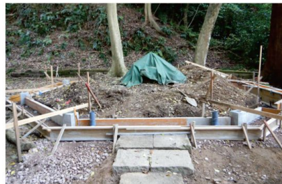
母儀人基社基壇整備 基礎工事状況
