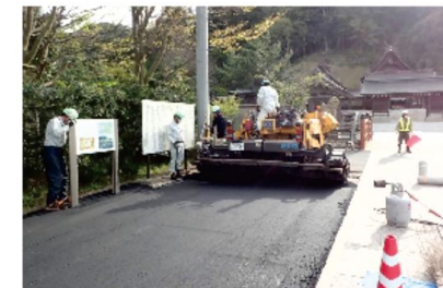
縦馬場南側 表層工敷均し状況
