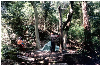
母儀人基社基壇整備 樹木伐採状況
