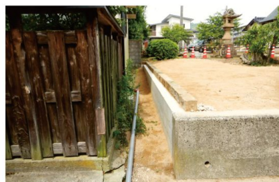
田中神社 南側擁壁改修 完成
