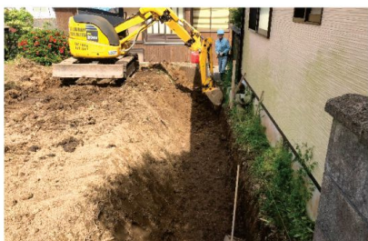
田中神社 南側擁壁改修工事状況
