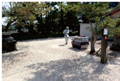
宇多貴社跡 路盤工転圧状況
